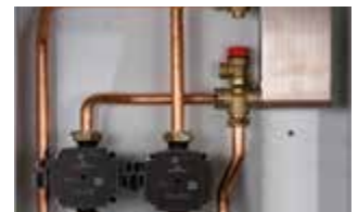
Kit separatore impianto a piastre con 2 circolatori per termocamini Plate Separator Kit with 2 circulators for thermo fireplaces
